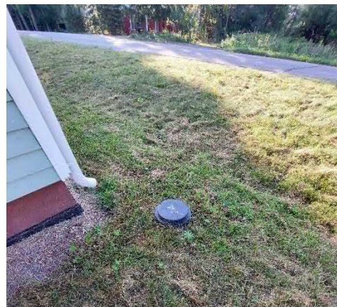
Sadevedet johdettu rännisyöksyä pitkin sokkelin viereen.
