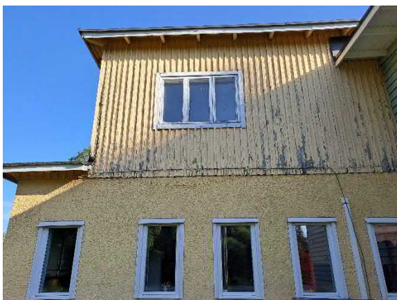
Alkuperäisen osan ikkunoita länsijulkisivulla
