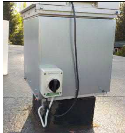
Huippuimurin sähköistystä vesikatolla
