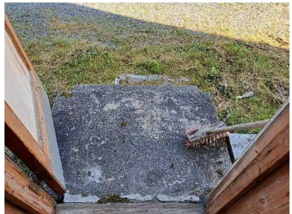
Betoniporras alkuperäisellä osalla
