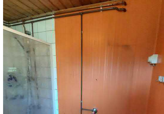
Kiinteistön alkuperäisen rakennusosan saneerattuja käyttövesijohtoja pesuhuoneessa.
