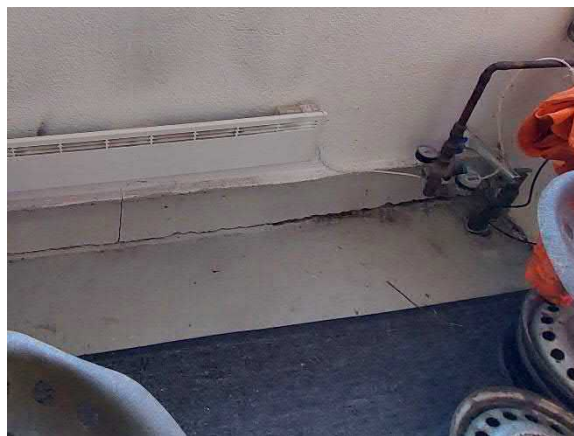
Halkeama ulkoseinä-alapohjaliittymässä
