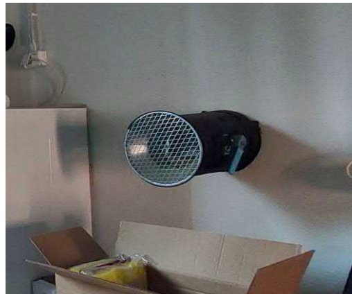
Laajennusosan korvausilmaventtiili.
