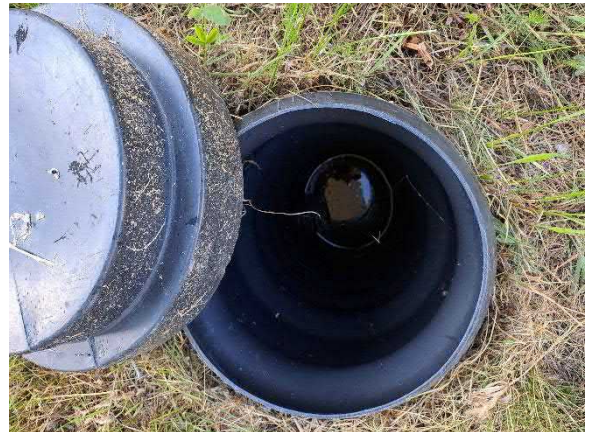
Salaojan tarkastuskaivoissa ei havaittu puut- teita tai vaurioita
