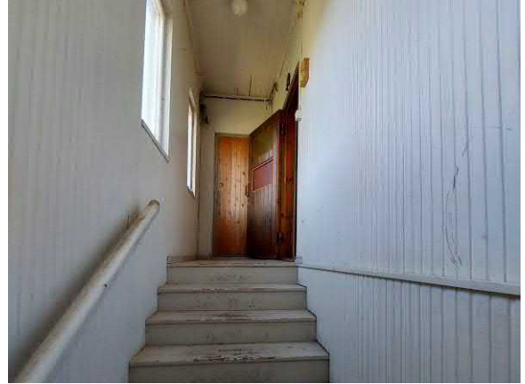
Alkuperäisiä puuväliovia 2. kerroksessa
