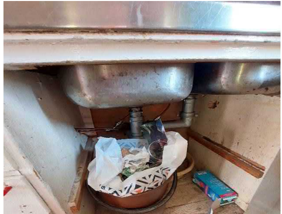
Kiinteistön alkuperäisen rakennusosan pesualtaan viemärointi.
