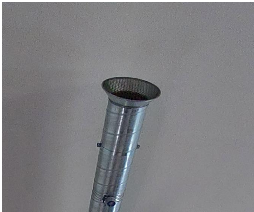
Laajennusosan poistoilmapäätelaitte.
