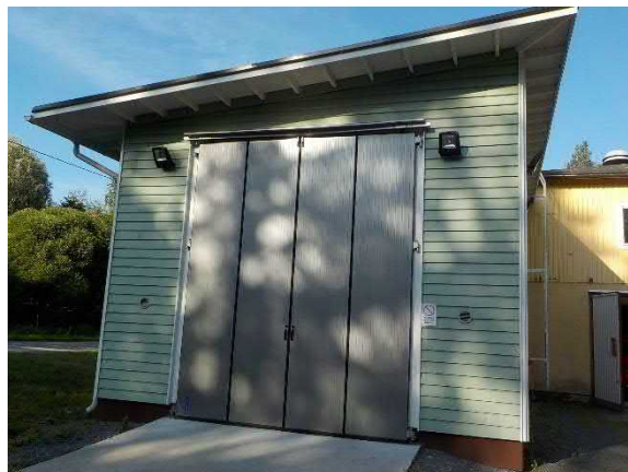
Laajennusosan autotallin taitto-ovi
