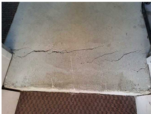
Halkeamia laajennusosan alapohjarakenteessa
