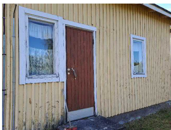
Alkuperäisen osan ikkunoita ja ovi itäjäulkisivulla
