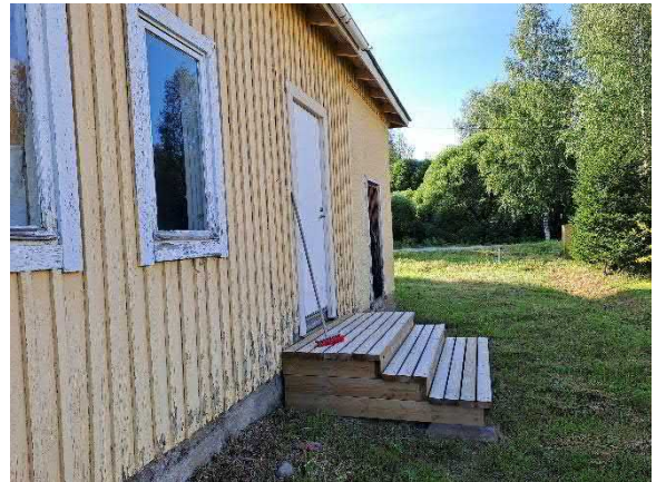
Puurakenteiset portaat alkuperäisellä osalla
