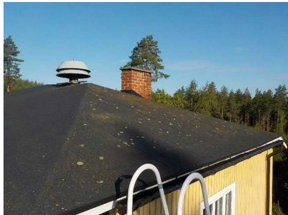
Alkuperäisen osan vesikatto
