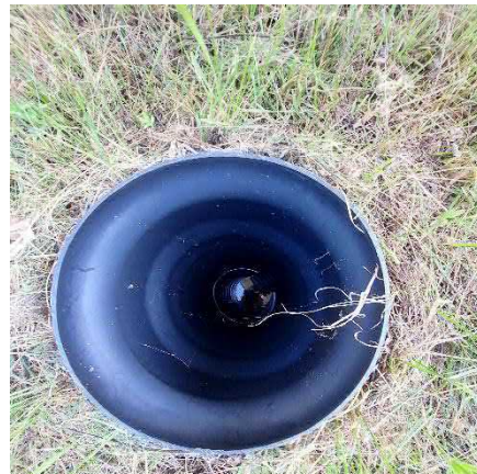
Kiinteistön laajennusosan salaojakaivo.
